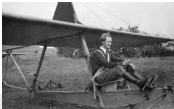
La silhouette caractéristique du SG 38 en vol : mât haubané, tendeurs qu'il fallait vérifier soigneusement avant chaque vol. Ci-dessous, le 30.9.1945 : Hubert Muller sanglé sur le SG 38, prêt pour un lancer au sandow. A l'arrière plan, le chariot pour déplacer le planeur.
